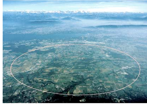
Nella foto: visione aerea del tunnel sotterraneo del Cern fra Francia e Svizzera
